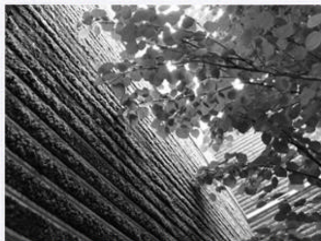
光庭外壁施工例
